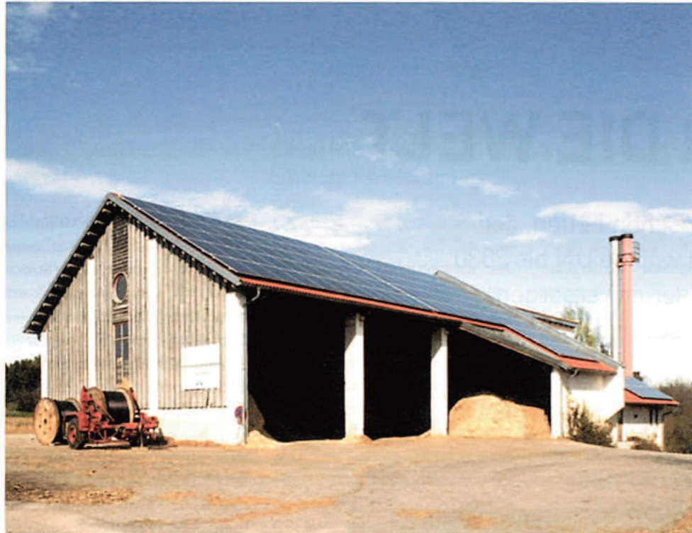
links oben: Das Hackschnitzel-Heizwerk liefert Wärme und bald auch Strom. links unten: Solar auf der Haube – rund drei Viertel der gesamten Energie gewinnen die Further umweltverträglich in Eigenregie.
